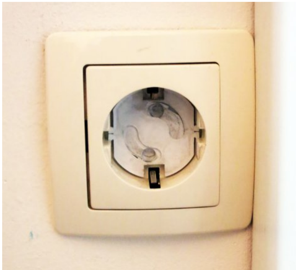
13: Enchufe con protector de seguridad.
